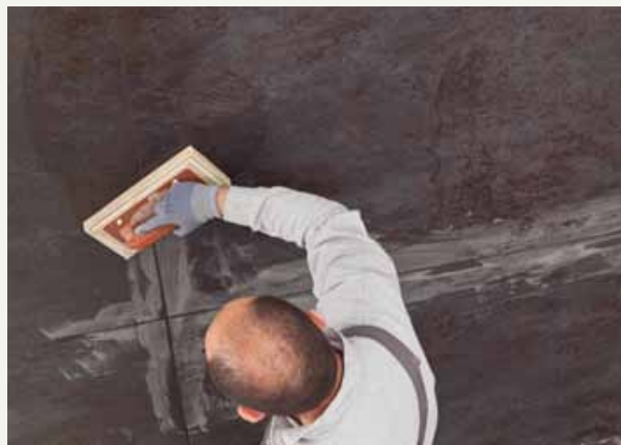
fig.39 / Затирка швов.
