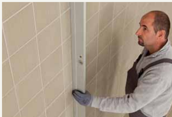
fig.34 /Проверьте ровность облицовываемой стены
